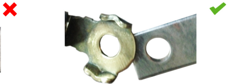
Obr. 2: Uzemnění po vyčištění: Dobrý kontakt
