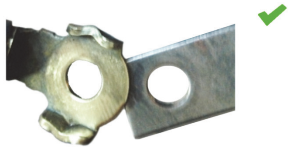
Рис. 2: Соединение с массой после очистки: хороший контакт
