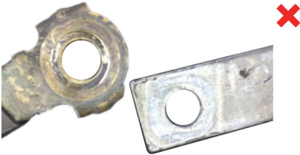
Рис. 1: Соединение с массой перед очисткой: плохой контакт
