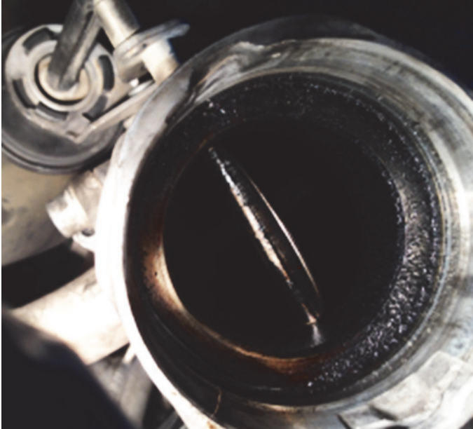
Εικ. 4: Απόθεση άνθρακα στο κλαπέτο της βαλβίδας του συστήματος επιστροφής αερίων (AGR)
