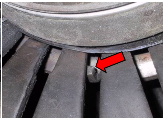
Rys. 2: Niepoprawna pozycja kołka prowadzącego pierścienia wyciskowego sprzęgła – kołek przesunął się pod sprężynę membranową
